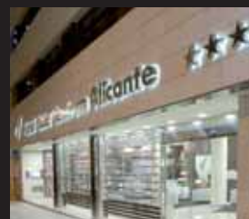
abba Centrum Alicante hotel - ALICANTE
